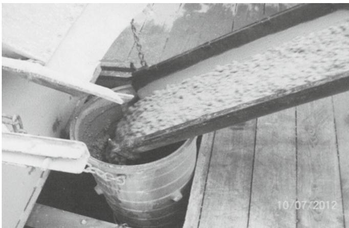
Blick auf die Teufe mit dem Füllrohr für den Beton.
